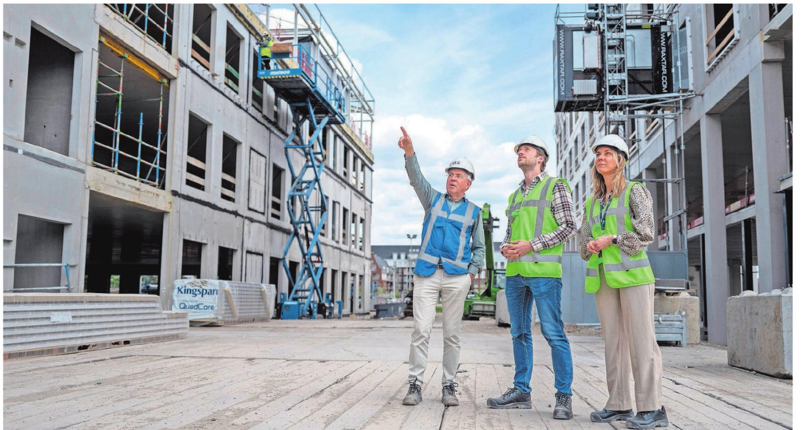
▲ Wessel Griffioen geeft een rondleiding bij de nieuwbouw van het ETZ, op de achtergrond De Leyhoeve. FOTO JORIS BUIJS/PIX4PROFS
