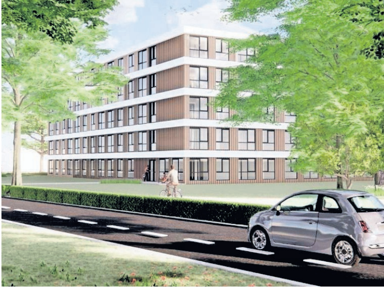
▲ Zicht vanaf de Ringbaan-Zuid op het nieuwbouwcomplex gemengd wonen. De nieuwbouw zal naar verwachting in het najaar van 2023 gereed zijn. ARTIST'S IMPRESSION JAN SNEL DAIWA HOUSE GROUP
